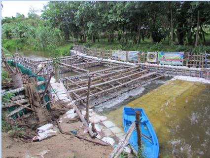
*Las presas de contención son estructuras temporales relativamente pequeñas construidas a lo largo de una ciénaga o canal. Se utilizan para disminuir la velocidad de los flujos de agua concentrada, una práctica que ayuda a reducir la erosión.*
